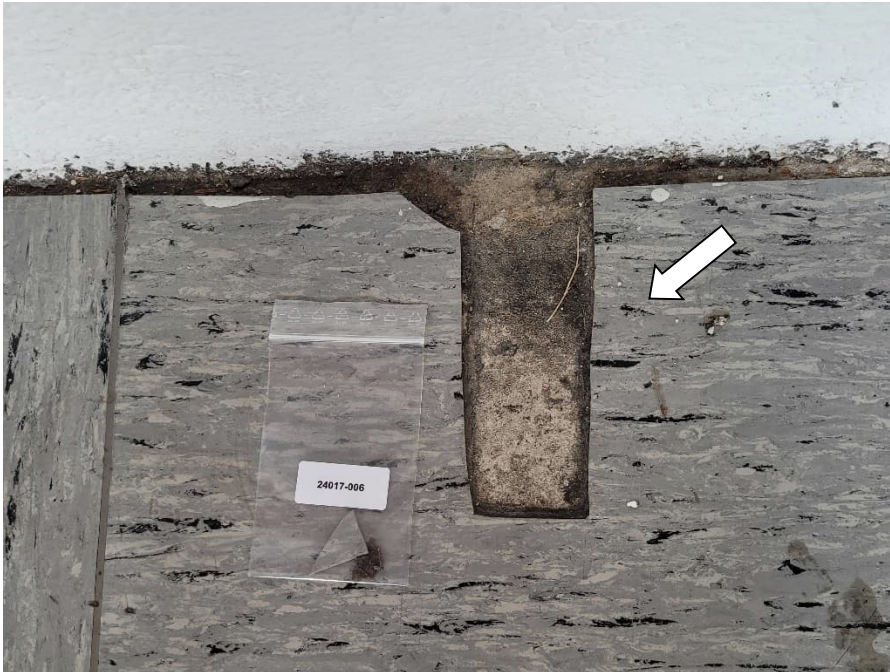
EG, Gruppenraum PVC-Belag mit Bodenbelagskleber (Probe 24017-006: kein Asbest nachgewiesen)
