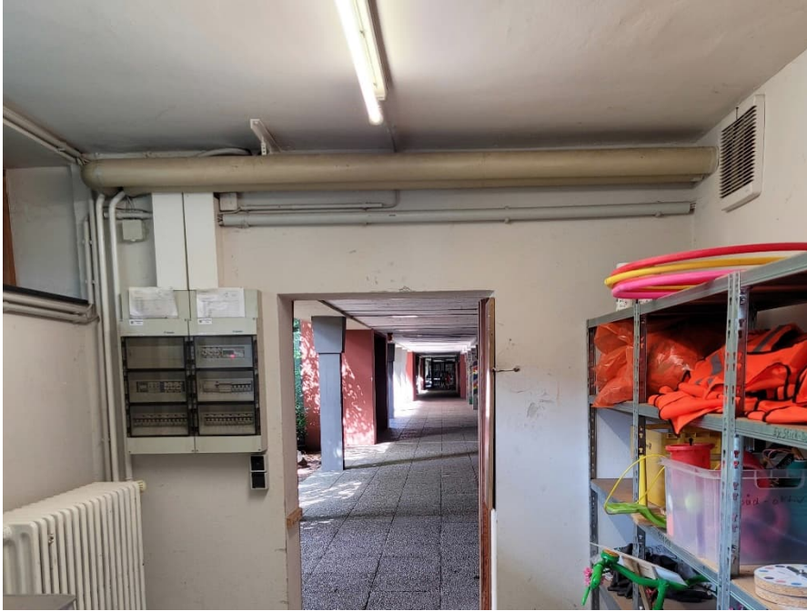
Asbesthaltige Dichtungen und KMF-haltige Isolierungen an technischen Anlagen
